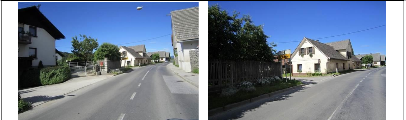
Slika 21: Nepregledni dovozi na glavno cesto (predvsem iz vasi Dornice). Omenjena lokacija potrebuje prehod za pešce.
