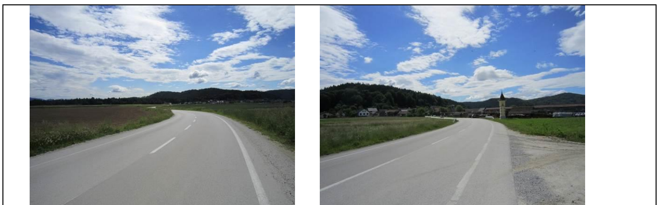
Slika 36: Nevarna cesta na relaciji Vodice–Bukovica brez pločnika.
