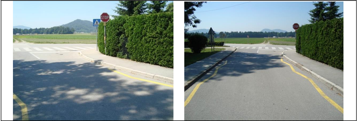
Slika 13: Nepregledno vključevanje vozil iz ulice Ob šoli na cesto Franca Seška zaradi visoke žive meje.
