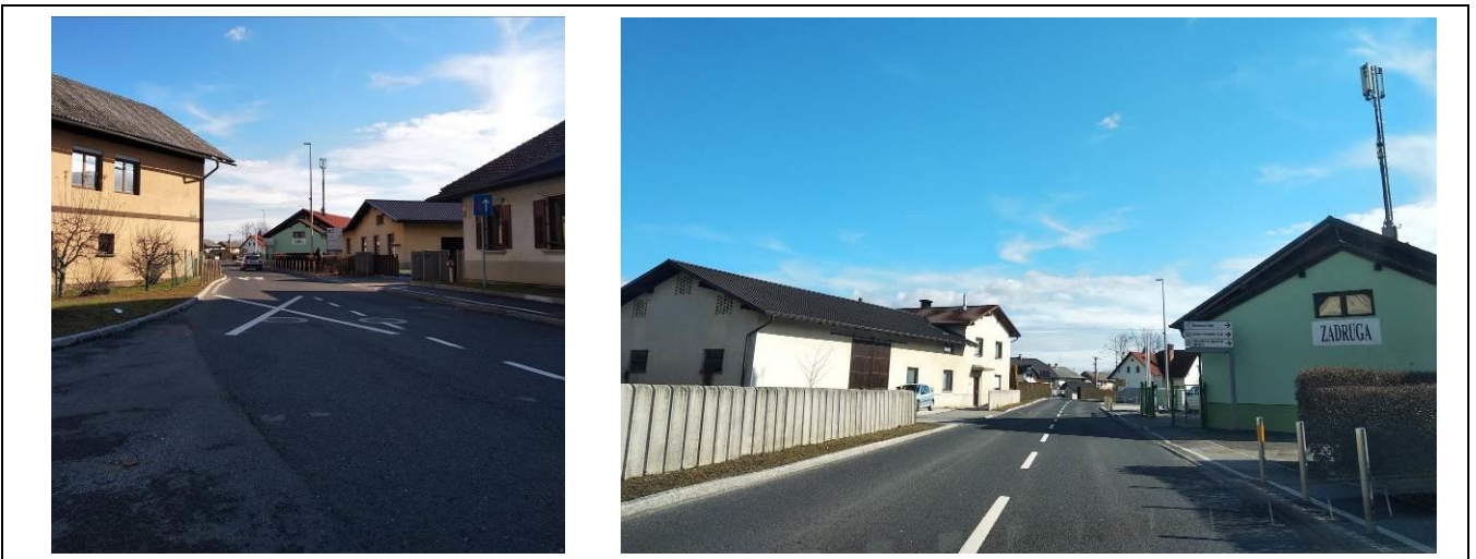
Slika 6: Neustrezno umirjanje prometa, večji zastoji.
