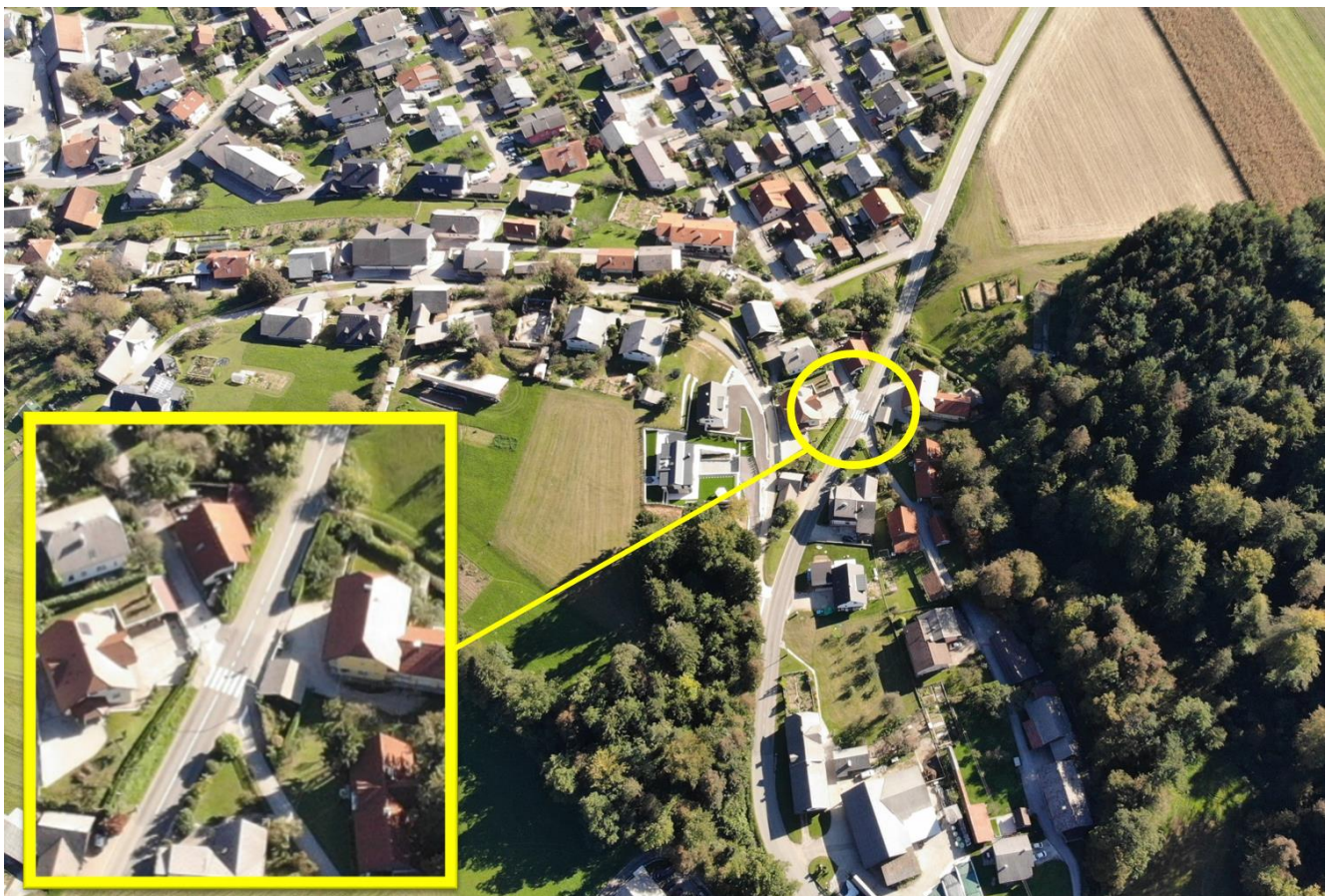
Slika 17: Ustrezna umestitev in osvetlitev prehoda za pešce.
