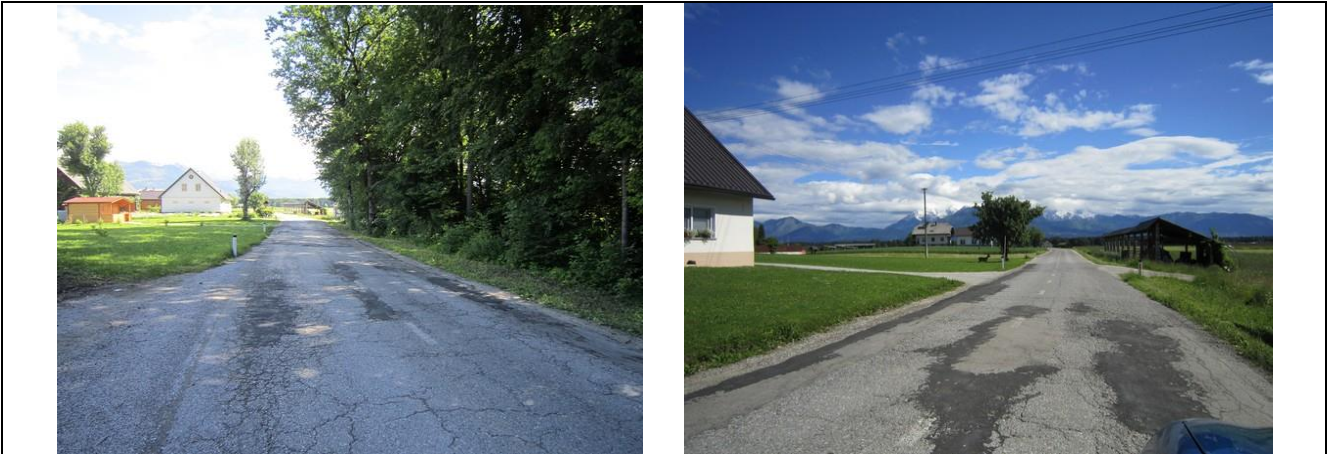
Slika 24: Nevaren odsek ceste brez pločnika do avtobusne postaje Benk, zaradi velikih hitrosti vozil.
