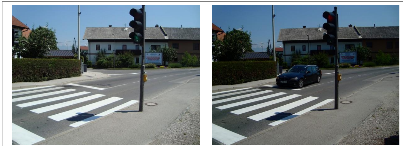
Slika 18: Vozniki večkrat ne upoštevajo rdeče luči na semaforju za pešce na Kopitarjevem trgu.
