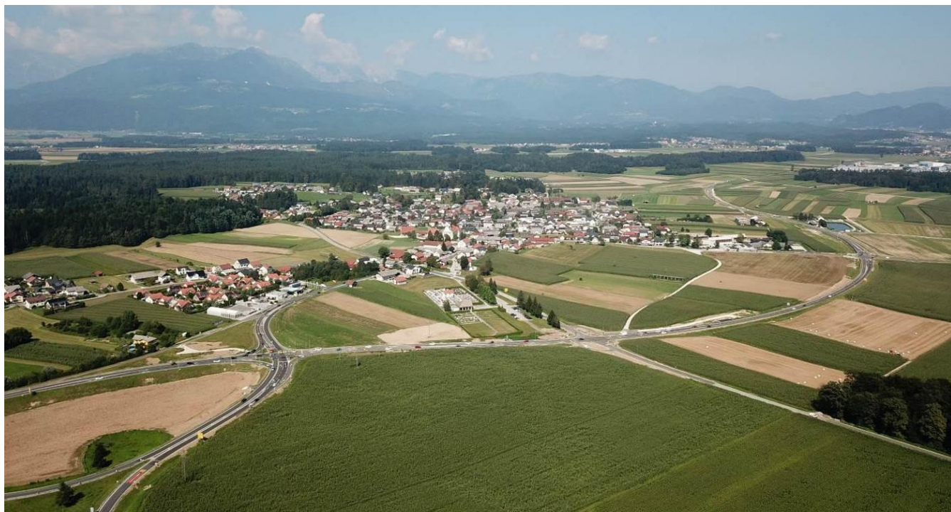
Slika 12: Novo zgrajena obvoznica Vodice – pogled na pokopališče in AC priključek
