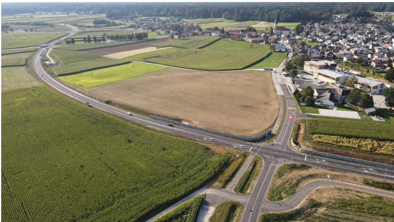
Slika 10: Novo zgrajena obvoznica Vodice – pogled proti AC priključku.
