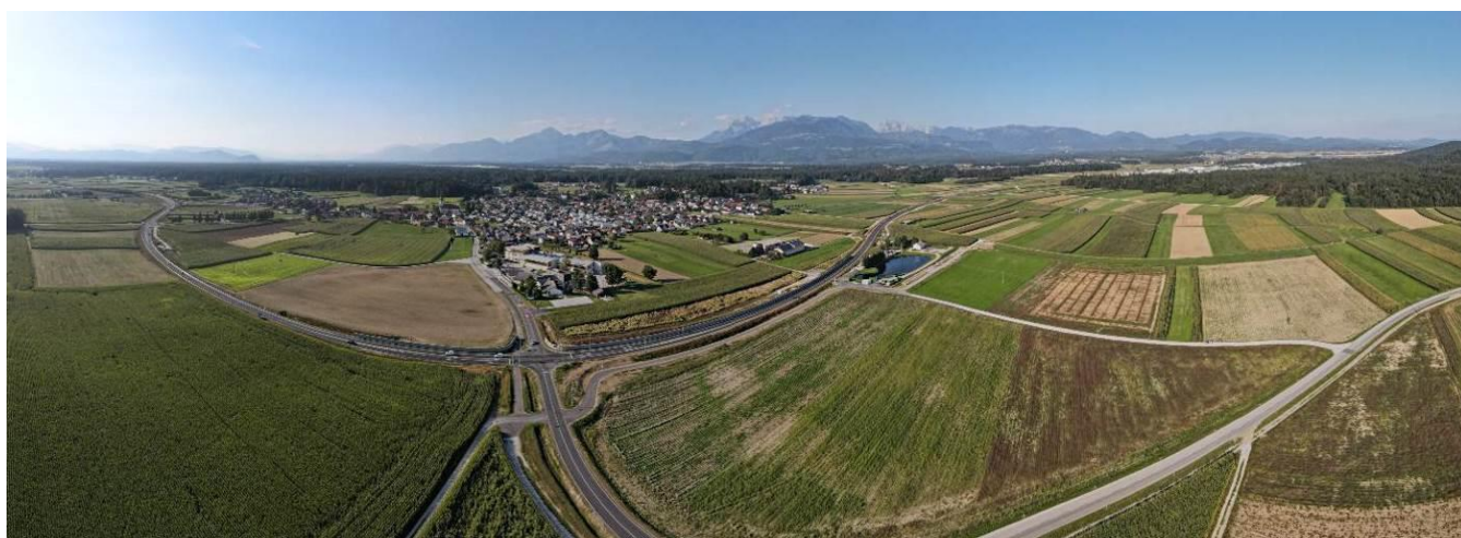
Slika 5: Novo zgrajena obvoznica Vodice – panoramski pogled na celotno traso.
