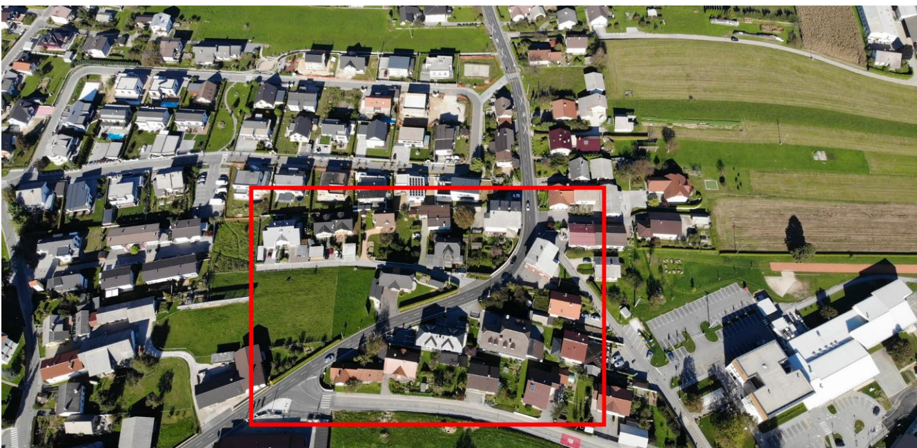
Slika 17: Odsek Kamniške ceste brez pločnika in brez prehoda za pešce – nevaren odsek.
