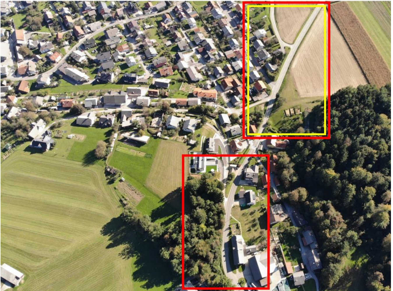
Slika 30: Brniška cesta brez pločnika – posnetek iz zraka.
