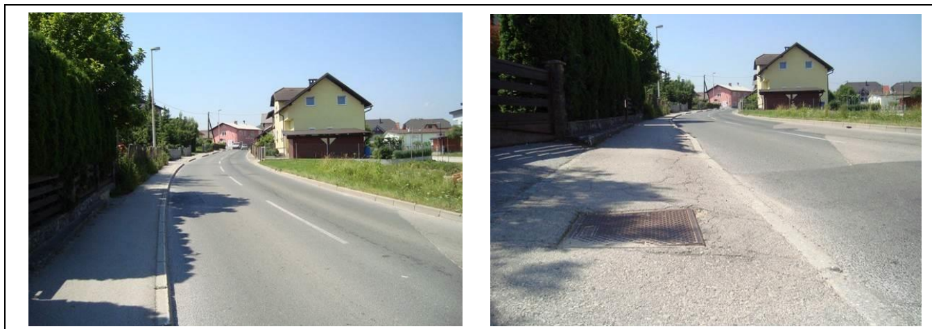
Slika 19: Pločnik na tej cesti je preozek in nevaren zaradi nagiba na cesto (predvsem pozimi).
