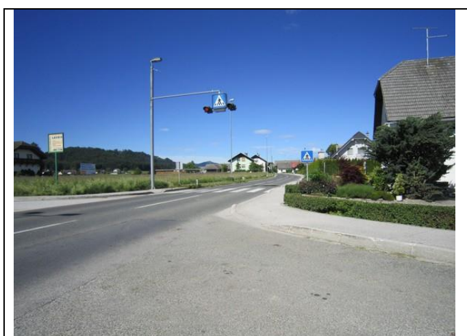
Slika 35: Prehod za pešce pri avtobusni postaji in radar za omejitev hitrosti.
