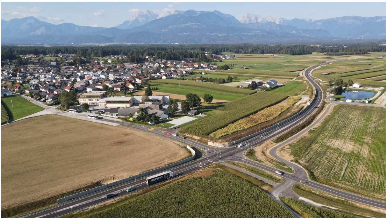
Slika 6: Novo zgrajena obvoznica Vodice pred šolo.
