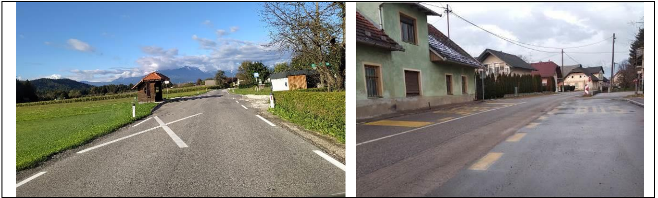
Slika 41: Brez prehodov za pešce na avtobusnih postajališčih.
