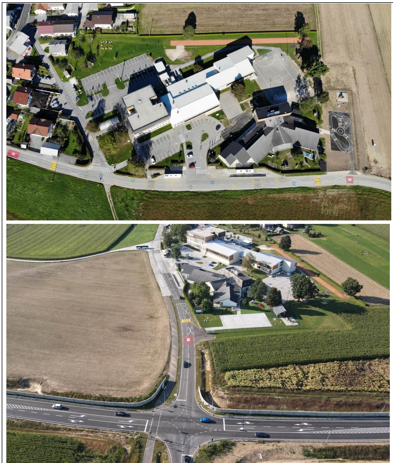
Slika 22: Ustrezne talne označbe ob šoli in urejeni prehodi za pešce.
