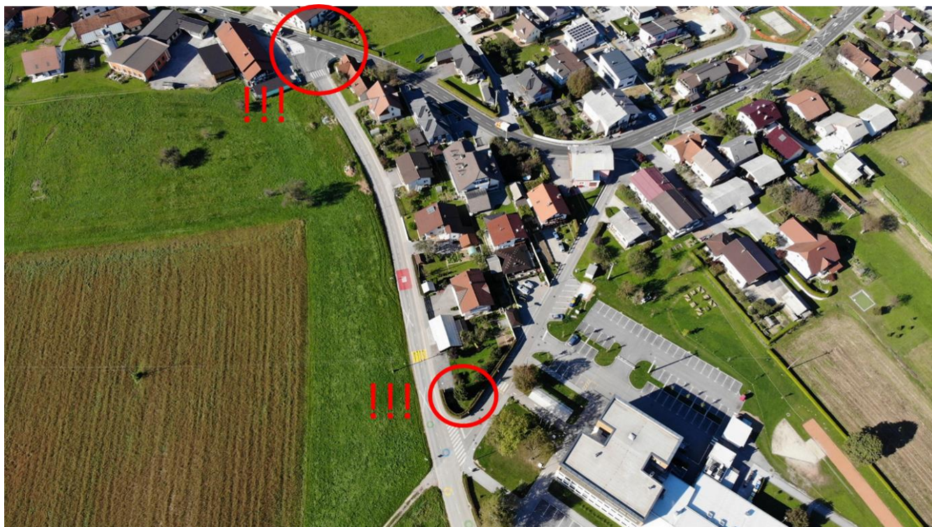
Slika 23: Neustrezna umestitev prehoda za pešce in nepregledno območje zaradi žive meje.
